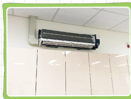
寒假期間辦理校舍 冷氣清洗保養作業4
