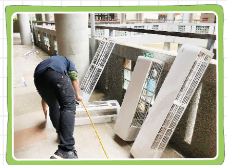
寒假期間辦理校舍 冷氣清洗保養作業1
