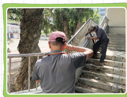
辦理活動中心側梯增設安全 防護欄桿確保學童安全3
