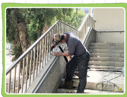
辦理活動中心側梯增設安全 防護欄桿確保學童安全2
