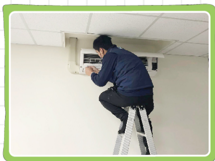
寒假期間辦理校舍 冷氣清洗保養作業2
