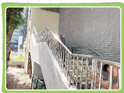
辦理活動中心側梯增設安全 防護欄桿確保學童安全4
