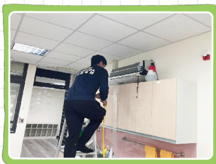
寒假期間辦理校舍 冷氣清洗保養作業3
